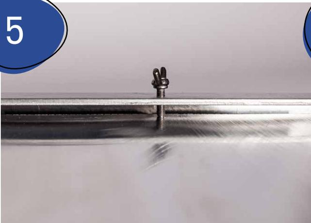
Aluminium Dammbalken in gewünschter Stauhöhe einsetzen und mit Flügelschrauben fixieren.
