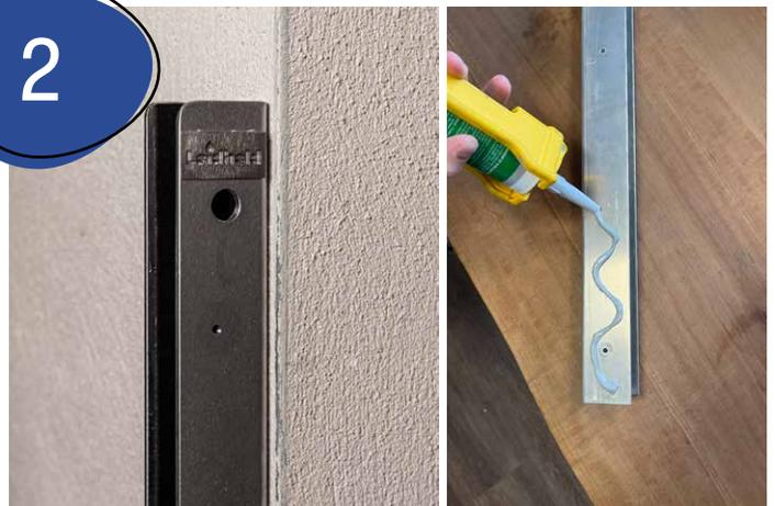
Montage der U-Profile an der Mauer (Tipp: mit Wasserwaage) Anzeichnen der Bohrlöcher – Abdichten und verschrauben der Wandprofile zur Mauer
